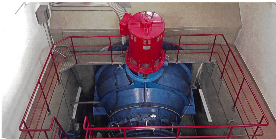
Bild 1. Beispiel einer Turbine-Generator-Komposition eines Kleinwasserkraftwerks.
