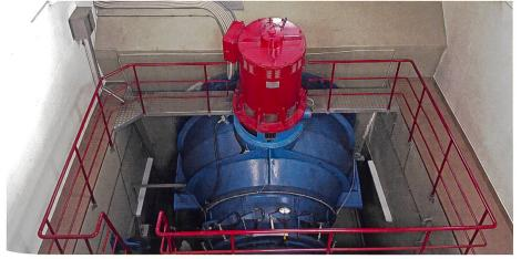
Bild 1. Beispiel einer Turbine-Generator-Komposition eines Kleinwasserkraftwerks.
