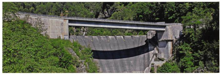
Bild 2. Neues HWE-Einlaufbauwerk ohne Wehrbrücke der Stauanlage Palagnedra, Kanton Tessin (Foto: Ofima).
