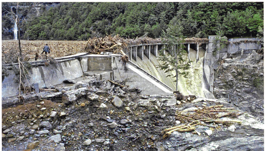
Bild 1. Verklausung der Hochwasserentlastung der Talsperre Palagnedra, Kanton Tessin, während des Hochwasserereignisses 1978 (Foto: Ofima).
