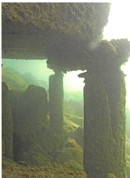
Ufermauer vor Sanierung.
