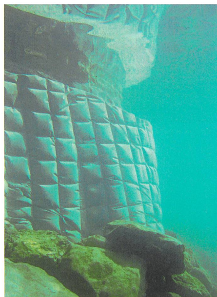
Ufermauer nach Sanierung.
