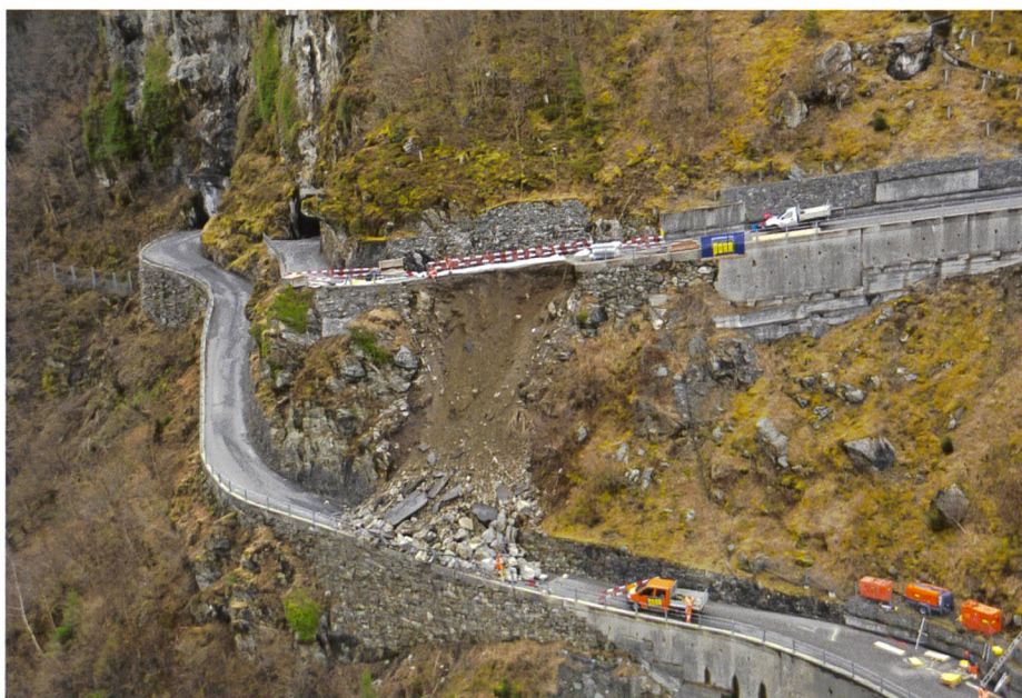
Bild 6. Ein 10 m langes Teilstück der Kantonsstrasse von Amsteg nach Bristen UR stürzte am 5. März ab (Foto: Baudirektion, Kanton Uri).
