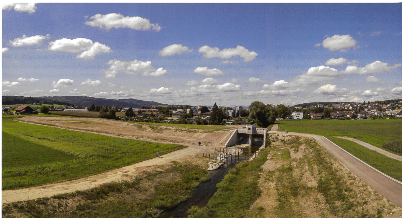
Bild 5. Hochwasserrückhaltebecken Wohlen, Querdamm und Durchlassbauwerk (Jonin Zumsteg).
