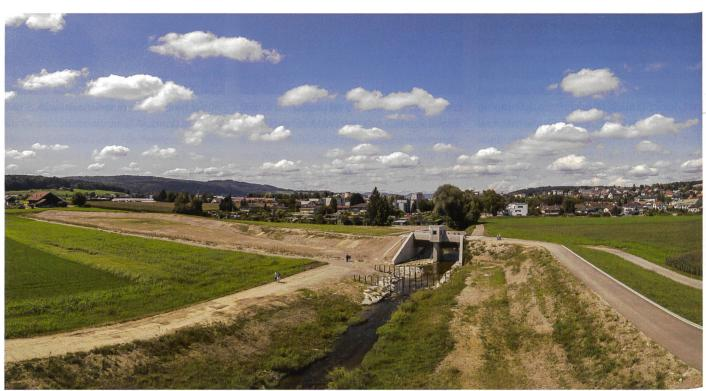
Bild 5. Hochwasserrückhaltebecken Wohlen, Querdamm und Durchlassbauwerk (Jonin Zumsteg).
