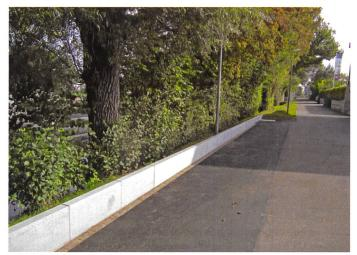
Bild 9. Teilausbau Bünz Wohlen, Ufererhöhung mit Winkelplatten und Erddamm (Seippel Landschaftsarchitekten GmbH).
