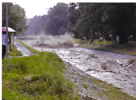
Bild 2. Abflauen einer instationären Welle am Geschiebetriebkanal Alpnach an der Kleinen Schliere beim Hochwasserereignis im August 2005 (Bezzola und Hegg, 2008).
