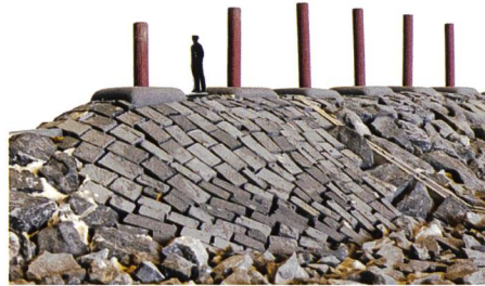
Bild 14. Modell des Landschaftsarchitekten im Massstab 1: 50 als Vorlage für die Bauausführung: Übergang Wehrschwelle – Längsdamm, leicht vorstehende Köcherfundamente.
