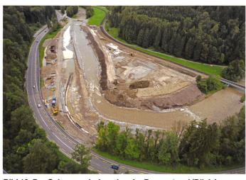
Bild 10. Der Schwemmholzrechen im Bauzustand (Blick in Fliessrichtung): Die Sihl fliesst bereits in ihrem neuen Bett.
