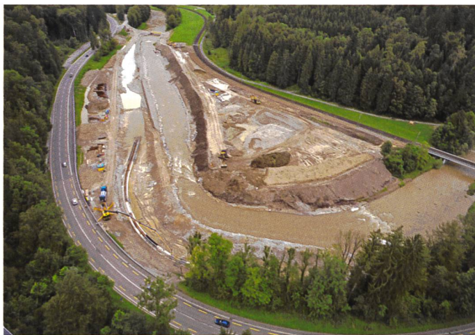
Bild 10. Der Schwemmholzrechen im Bauzustand (Blick in Fliessrichtung): Die Sihl fliesst bereits in ihrem neuen Bett.
