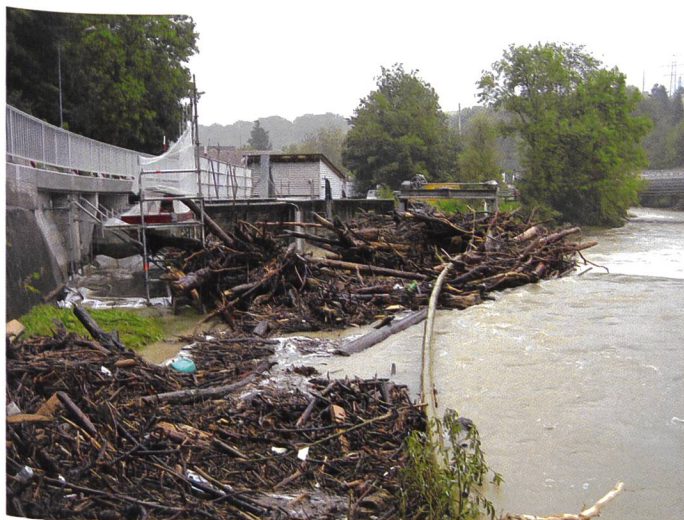
Bild 5. Schwemmholaufkammerung nach dem Hochwasser von 2005 bei Langnau am Albis (Blick in Fliessrichtung).
