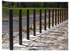
Bild 13. Die Rechenstäbe aus Stahl sind ausbetoniert und oben mit einer Stahl-kappe geschlossen. Die leicht vorstehenden Köcherfundamente zeigen die Verankerung der Rechenstäbe im Fundament. Die Stäbe des Querrechens stehen auf Terrainhöhe des Rückhalteraums.
