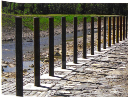
Bild 13. Die Rechenstäbe aus Stahl sind ausbetoniert und oben mit einer Stahlkappe geschlossen. Die leicht vorstehenden Köcherfundamente zeigen die Verankerung der Rechenstäbe im Fundament. Die Stäbe des Querrechens stehen auf Terrainhöhe des Rückhalterums.
