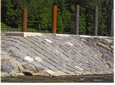
Bild 15. Umgesetzte Vorgabe am Bau: Die Übergänge zum Uferblocksatz aus formwilden Alpenkalksteinen bestehen aus gerichteten Quarzsandsteinen.
