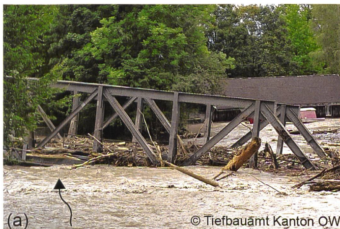
Bild 1. (a) Verklausung der Eisenbahnbrücke Sarnen, Kanton OW, und (b) Verklausung bei einem Brückenpfeiler, Tirol, Österreich.
