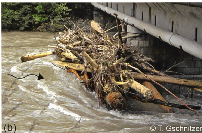
Bild 1. (a) Verklausung der Eisenbahnbrücke Sarnen, Kanton OW, und (b) Verklausung bei einem Brückenpfeiler, Tirol, Österreich.
