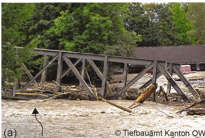
Bild 1. (a) Verklauung der Eisenbahnbrücke Sarnen, Kanton OW, und (b) Verklauung bei einem Brückenpfeiler, Tirol, Österreich.
