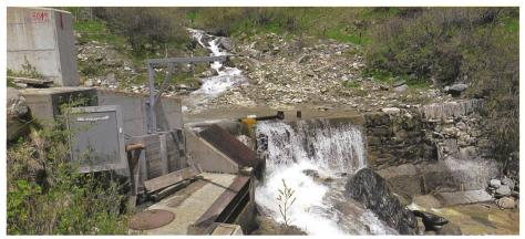
Bild 2. Der erste Coanda-Rechen der Schweiz kam 1998 am Räppierbach in der Gemeinde Hinterrhein (GR) zum Einsatz. Der Stababstand des einen Meter breiten Rechens beträgt 1 mm, die Schluckfähigkeit 140 l/s. Auf dem Bild liegt der Coanda-Rechen unterhalb des Schutzrostes versteckt. Der Rost dient dazu, bei Hochwasser grosse Steine vom Coanda-Rechen fernzuhalten.
