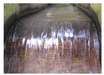
Bild 4. Nahaufnahme eines Coanda-Rechens: Die horizontalen Metallstäbe wirken wie Rasierklingen, die das Wasser schichtenweise abscheren.
