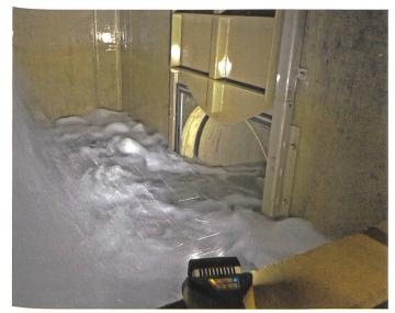
Bild 9. Blick auf die offene Schütze DN1000; der Weg führt direkt ins Triebwasser des WKW Matten. Der Standort des Fotografen befindet sich hinter der Überlaufkante, über welche das turbinierte Wasser direkt in den Albristbach geleitet werden kann (Juni 2016).
