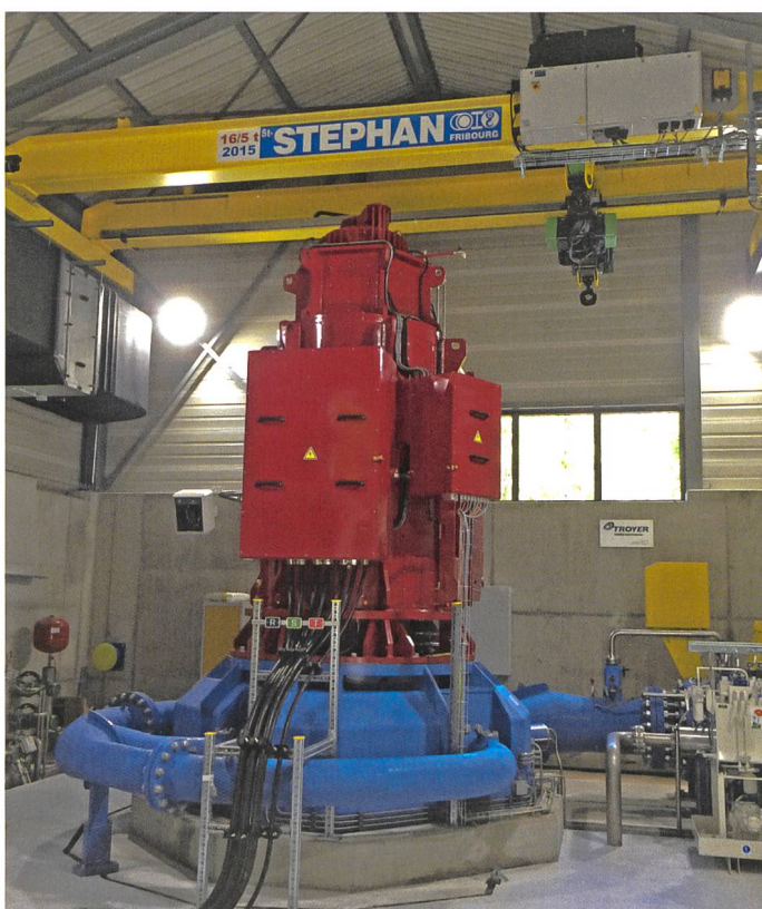
Bild 10. Blick auf die Pelton turbine in der Zentrale Matten.
