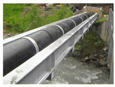
Bild 20. Rohrbrücke mit isolierter Druckleitung DN 600 (Mai 2015).
