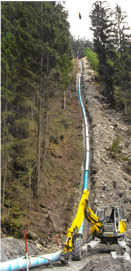
Bild 18. Verlegte Druckleitung DN400 im Steilhang Albrist (Aug. 2015).
