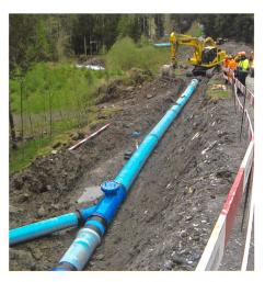
Bild 19. Druckleitung DN600 mit Vereinigung und Inspektionsöffnung (April 2015).
