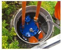
Bild 21. Inspektionsöffnung mit Entlüftungsventil Hochpunkt Düker (Mai 2016).
