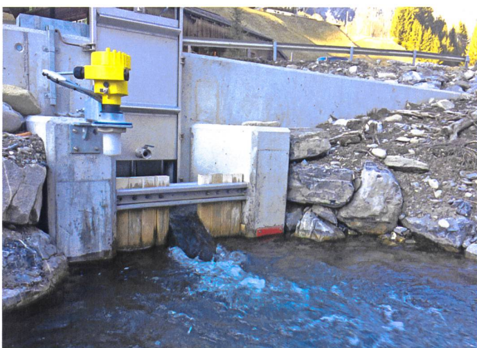
Bild 6. Blick (gegen die Fliessrichtung) auf das Einlaufbauwerk des Umgehungsgerinnes mit Restwasserabgabe. Die Pegelmessung ist oben links ersichtlich, die rote Markierung in der Mitte des Bildes stellt die optische Überprüfung der Restwassermenge dar (März 2017).
