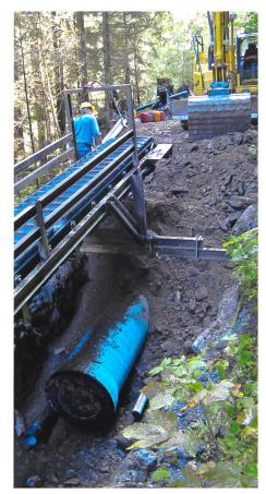
Bild 17. Bau der Druckleitung DN600 im alten Fermelweg; der Aushub wird direkt wieder für die Hinterfüllung des vorher verlegten Rohres benutzt (Aug. 2014).
