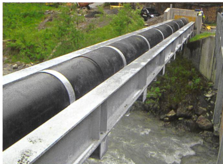
Bild 20. Rohrbrücke mit isolierter Druckleitung DN 600 (Mai 2015).
