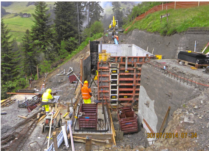
Bild 13. Bau der unterirdischen Zentrale Albrist mit Zusammenschluss Druckleitung im Hintergrund (Juli 2014).
