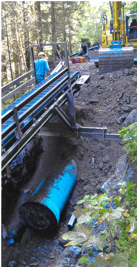
Bild 17. Bau der Druckleitung DN600 im alten Fermalweg; der Aushub wird direkt wieder für die Hinterfüllung des vorher verlegten Rohres benutzt (Aug. 2014).
