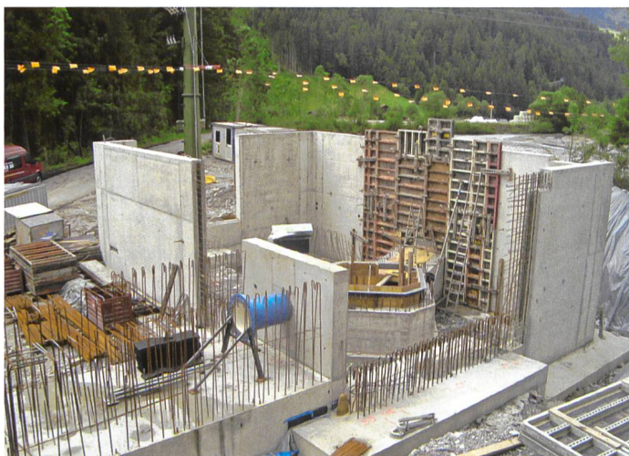
Bild 15. Blick auf die Zentrale Matten, links zukünftiger Fixpunkt (Bewehrung) und in der Mitte Turbinenstandort (Juni 2015).
