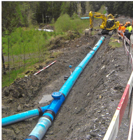
Bild 19. Druckleitung DN600 mit Vereinigung und Inspektionsöffnung (April 2015).
