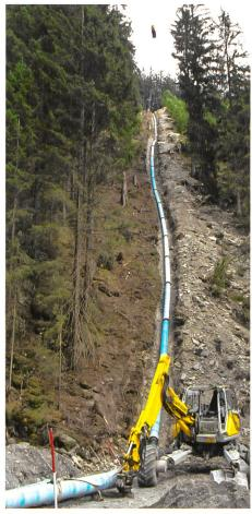
Bild 18. Verlegte Druckleitung DN400 im Steilhang Albrist (Aug. 2015).
