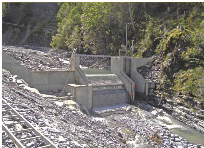
Bild 7. Fassung Albrist in Betrieb (Aug. 2015).
