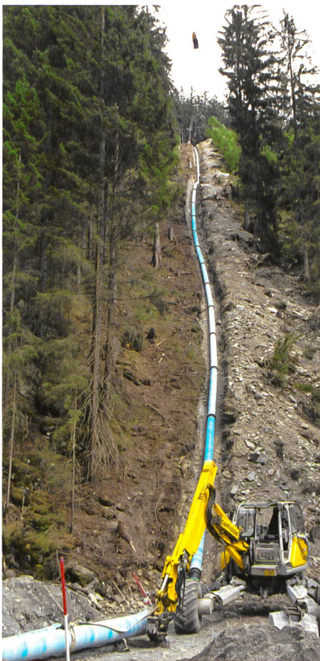
Bild 18. Verlegte Druckleitung DN400 im Steilhang Albrist (Aug. 2015).
