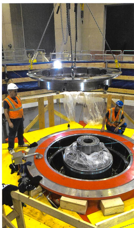
Montagearbeiten an der Maschine 2, noch ohne Rotor (Foto: SWV/Pfa).
