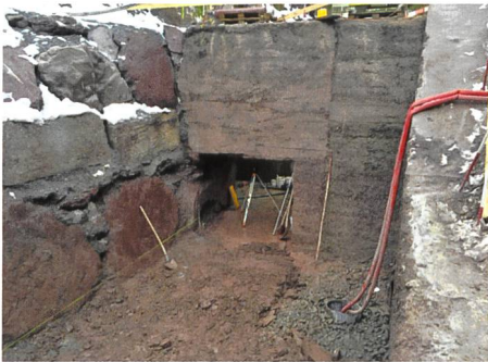
Bild 2. Für ein einfacheres Arbeiten wurde die Apparatekammer Bruggwiti oben komplett geöffnet.
