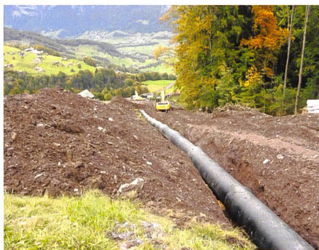
Bild 9. Montage der Druckleitung oberhalb der Zentrale Pravazin.
