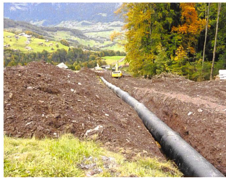
Bild 9. Montage der Druckleitung oberhalb der Zentrale Pravazin.
