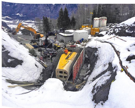
Bild 8. Übergang vom Stollen Marmiez (unten) und der Apparatekammer (oben) mittels eines vor Ort erstellten Konus aus Beton.
