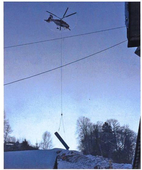
Bild 11. Einbau der neuen Druckrohre mit dem Helikopter «KAMOV».
