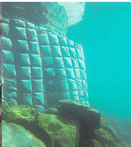
Ufermauer nach Sanierung.
