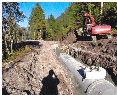
Bild 3. Die neue Druckleitung zwischen der Apparatekammer Bruggwiti und dem Druckstollen.
