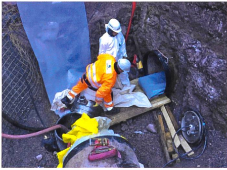
Bild 1. Blick in den Arbeitsschacht: Das Inlining wird in das alte Rohr eingezogen.
