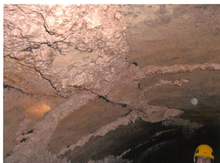
Bild 4. Vor der Sanierung: Einblick in den einbruchgefährdeten Druckstollen.
