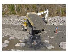
Bild 2. Ausführung einer ausgelösten unstrukturierten Blockrampe an der Kander: Die Blöcke werden auf das Planum aufgesetzt und anschliessend mit Untergrundmaterial überschüttet.
