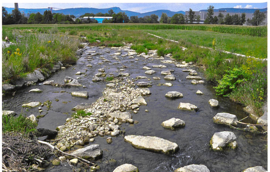
Bild 1. Aufgelöste unstrukturierte Blockrampe (UBR) an der Wyna (Kanton AG) mit einem spezifischen Abfluss q \approx 0.03 \text{ m}^3/(\text{s}\cdot\text{m}) , entspricht in etwa einem Niederwasserabfluss Q_{325} (Blick in Fliessrichtung).
