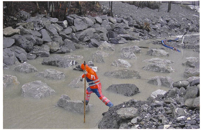
Bild 9. Kontrolle der Positionierung der Blöcke (Simme, Latterbach).
