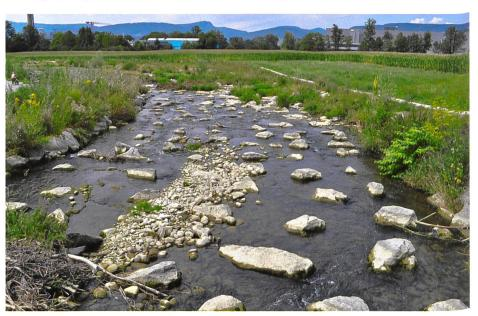
Bild 1. Aufgelöste unstrukturierte Blockrampe (UBR) an der Wyna (Kanton AG) mit einem spezifischen Abfluss  $q \approx 0.03 \text{ m}^3/(\text{sm})$ , entspricht in etwa einem Niederwasserabfluss  $Q_{329}$  (Blick in Fliessrichtung).
