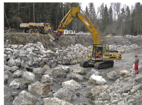
Bild 4. Anschluss der aufgelösten unstrukturierten Blockrampe an die Ufersicherung: Die Ufersicherung wird zuerst erstellt, dann werden die Blöcke der Rampe versetzt (Kander).
