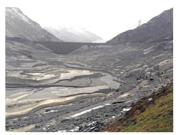
Bild 5. Foto vom leeren Stausee mit Erosionsrinnen (Bild: Steffen Schweizer).
