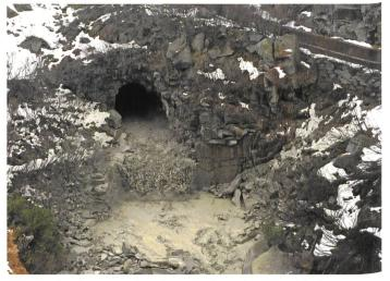
Bild 4b. Ausfluss aus dem Grundablass des Räterichsbodensees, November 2014 (Bild: Steffen Schweizer).
