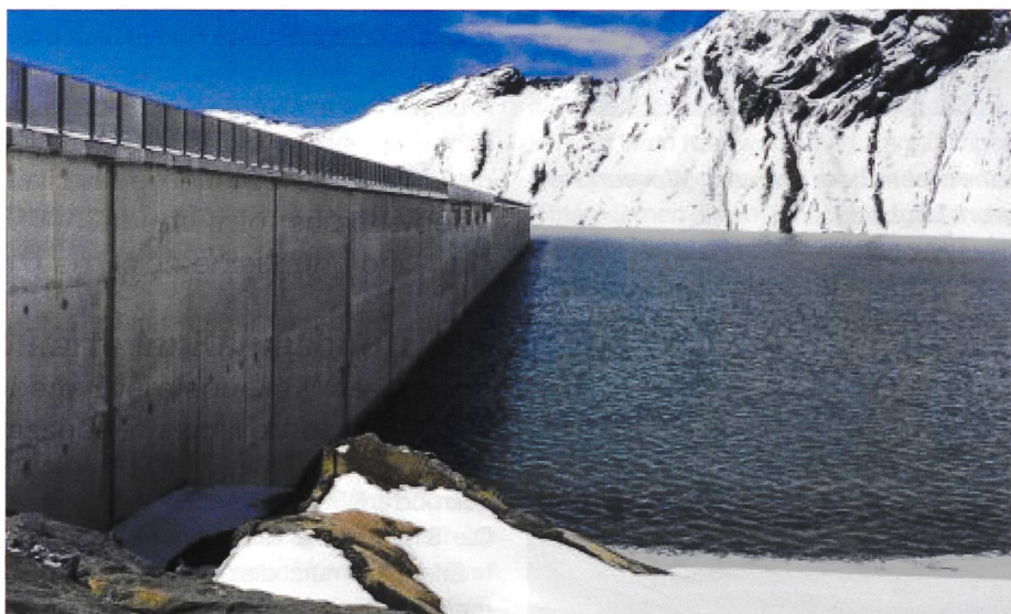
Bild 2. Teileinstau bei der neuen Talsperre Muttsee (Quelle: Axpo).
