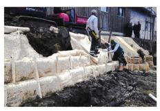
Bilder 2,3,4. Howolis-Q-Faschine: Verlegen der Q-Faschinen, Verpflockung und Befestigung der Faschine entlang des Ufers
