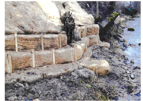
Bild 5. Howolis-Q-Faschine: Die flexiblen Holzwole-Faschinen erlauben die Verlegung entlang der individuellen Uferlinie. Ebenso lassen sich Rauigkeitselemente wie Kleinbuhnen und Sporne modellieren.
