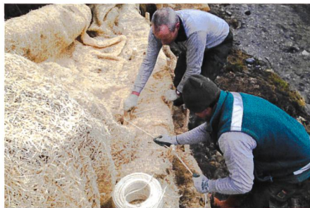
Bild 5. Howolis-Q-Faschine: Die flexiblen Holzwole-Faschinen erlauben die Verlegung entlang der individuellen Uferlinie. Ebenso lassen sich Rauigkeitselemente wie Kleinbuhnen und Sporne modellieren.
