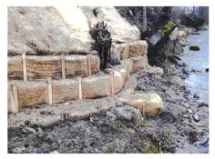
Bild 5. Howolis-Q-Faschine: Die flexiblen Holzwolle-Faschinen erlauben die Verlegung entlang der individuellen Uferlinie. Ebenso lassen sich Rauigkeitselemente wie Kleinbuhnen und Sporne modellieren.
