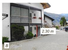
Bild 2 A. Kalibrierungsfoto eines Wohngebäudes (Fotograf unbekannt). B: Vor dem Ereignis bestehende Treppenlaube als Mass für die Abschätzung der Ablagerungshöhe (Foto Martin Seiler).
