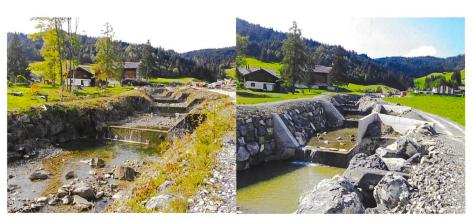
Bild 1. Ausleitstrecke mit klassischen Betonsperren vor dem Umbau (links) und nach der Fertigstellung mit erhöhten Flügeln, verengten Überfallsektionen und Ausleitspornen (rechts).
