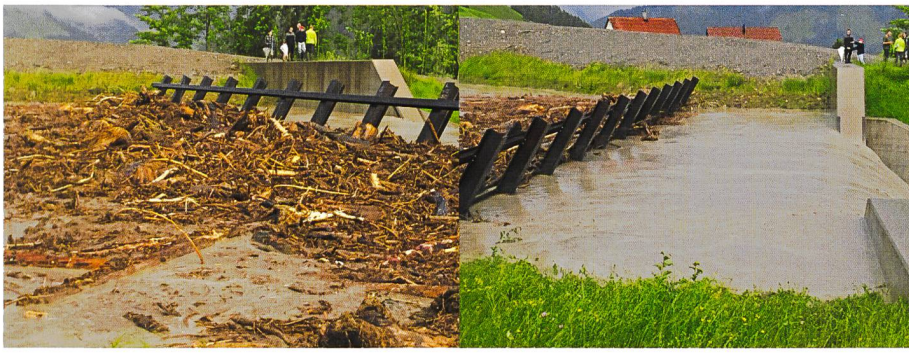
Bild 4. Holzablagerungen im Rechen (Fotos: R. Holdener).
