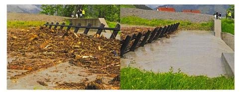
Bild 4. Holzablagerungen im Rechen (Fotos: R. Holdener).
