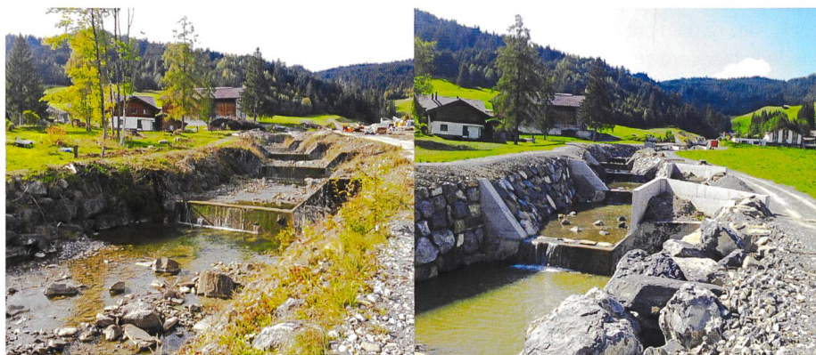
Bild 1. Ausleitstrecke mit klassischen Betonsperren vor dem Umbau (links) und nach der Fertigstellung mit erhöhten Flügeln, verengten Überfallsektionen und Ausleitspornen (rechts).
