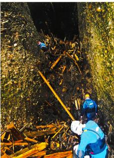
Bild 2. Links: Begehung der Verklausung der Brücke über den Sädelgrabe (Foto: Geotest AG); rechts: Verklausung im Räbloch (Foto: Feuerwehr Eggiwil).
