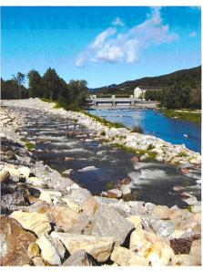
Bild 1. Umgehungsgewässer beim Kraftwerk Rupperswil. (Bild: MMi SWV).
