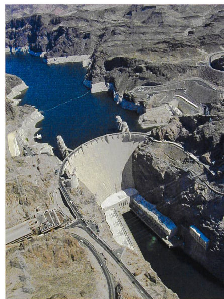
Bild 2. Hoover-Staudamm am Colorado-River bei Las Vegas, USA: 1935 fertiggestellt, 35 Mia. m 3 Volumen, für die Mehrzwecknutzung des Wassers (Trinkwasser, Bewässerung und Energie) (Foto: Pamela McCreight).
