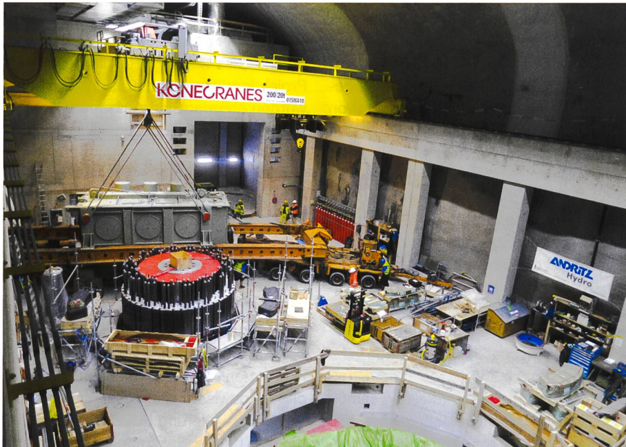
Bild 5. Kaverne Handeck 2E beim Generatortransport mit Abdichtungsfolie im Hinter- grund am Gewölbe.
