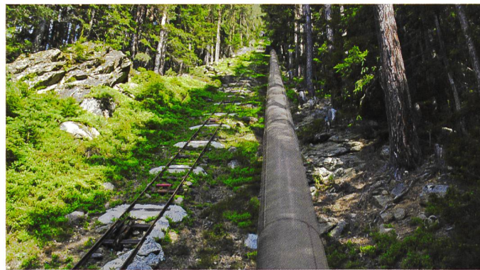
Bild 3. Die neue Druckleitung wird am gleichen Ort verlegt, jedoch teilweise unterirdisch geführt.
