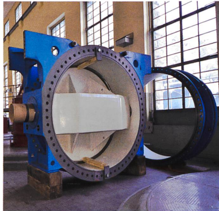
Bild 2. Die neue Drosselklappe ist zum Einbau bereit (KWO).
