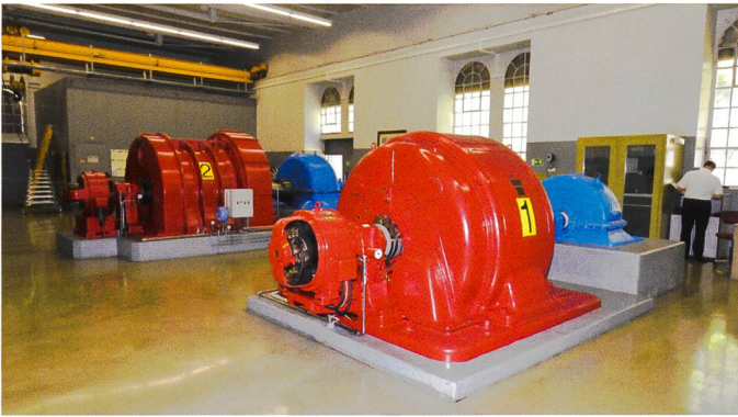
Bild 2. Die alten Maschinensätze aus dem Jahr 1942 werden durch neue Turbinen und Generatoren ersetzt, die eine Steigerung der Leistung von 6 MW auf 10 MW möglich machen.
