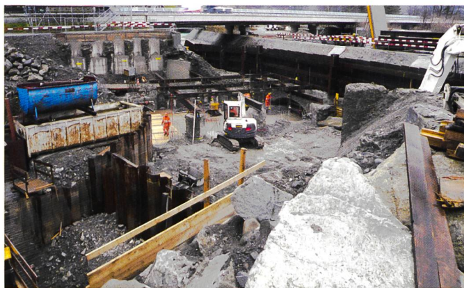
Bild 2. Bauzustand mit Stahlwand für Wasserhaltung, in der Mitte noch sichtbar der alte abzubrechende Bogendurchlass.
