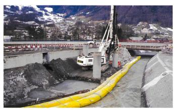
Bild 1. Erstellen der Bohrpfähle im Schächen.
