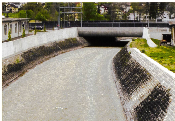
Bild 6. Druckbrücke mit Kragenmauern.
