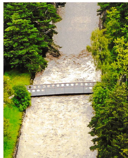
Bild 2. Der Wassersprung ob der Passe-Relle markiert die Front der gegen die Fliessrichtung wandernden Auflandungsfront (Aufnahme am 23. August 2005, Vormittag. Copyright TBA Kanton Uri).
