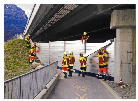
Bild 1. Einbau mobiler Dammbalkenelemente.
