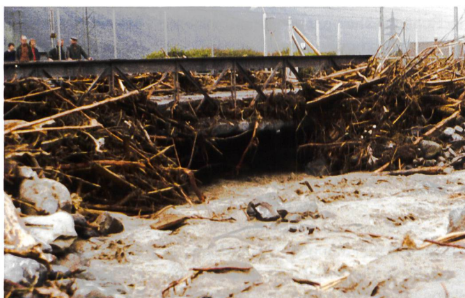
Bild 2. Verklauungen an der Schächenbrücke bei der RUAG im Juli 1977.
