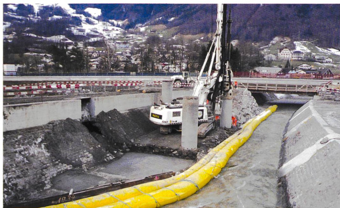
Bild 1. Erstellen der Bohrpfähle im Schächen.
