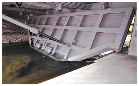
Bild 4. Skizzen (oben) und Foto des Hydraulischen Notverschlusses unter SBB-Brücke Stille Reuss.
