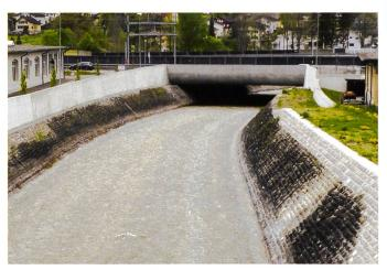
Bild 6. Druckbrücke mit Kragenmauern.
