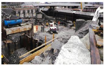
Bild 2. Bauzustand mit Stahlwand für Wasserhaltung, in der Mitte noch sichtbar der alte abzubrechende Bogendurchlass.
