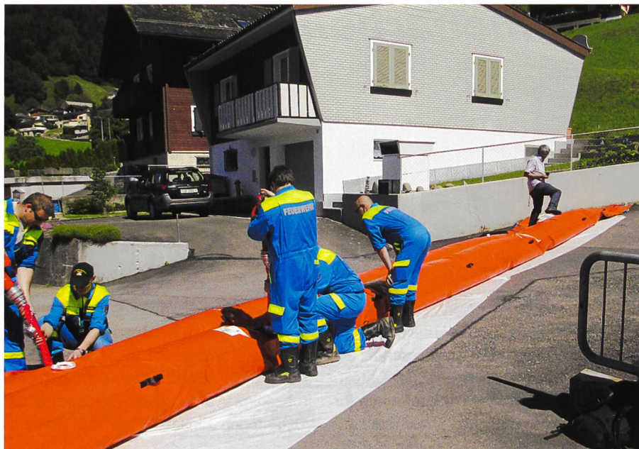
Bild 3. Einbau Beaver-Schläuche.
