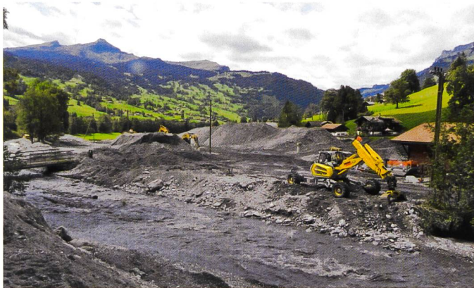
Bild 2. Geschiebeentnahmen an der Schwarzen Lutschine im Bereich Mättenbergbrücke in Grindelwald nach den Flutwellen im Jahr 2011 (Foto: Nils Hählen).
