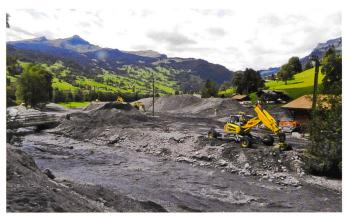
Bild 2. Geschiebeentnahmen an der Schwarzen Lütschine im Bereich Mättenbergbrücke in Grindelwald nach den Flutwellen im Jahr 2011 (Foto: Nils Hählen).
