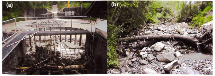
Bild 3. (a) Aufnahme des Geschiebesammlers des Erlenbaches mit abgelagerten Holzstücken verschiedener Grössen nach dem Ereignis vom 1. August 2010; (b) Aufnahme der Verklausung LJ1 am 19. Juli 2011, knapp ein Jahr nach dem ausserordentlichen Abflussereignis vom 9. August 2010.
