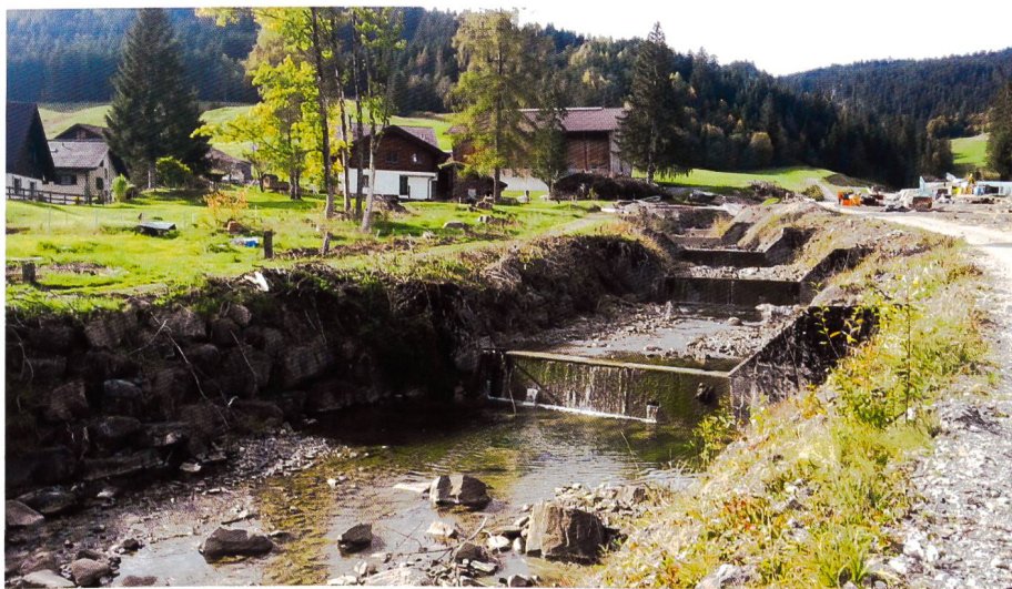
Bild 1. Ausleitstrecke mit klassischen Betonsperren vor dem Umbau.
