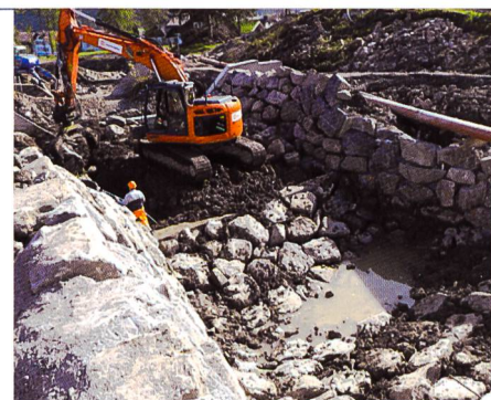
Bild 10. Kolkwanne, Prinzip und Bauausführung, Fliessrichtung im Foto von rechts nach links.
