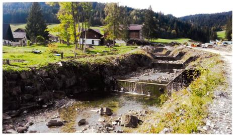
Bild 1. Ausleitstrecke mit klassischen Betonsperren vor dem Umbau.
