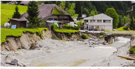
Bild 1. Ufererosion an der Trueb beim Hochwasser 2005. Foto: Flussbau AG SAH.
