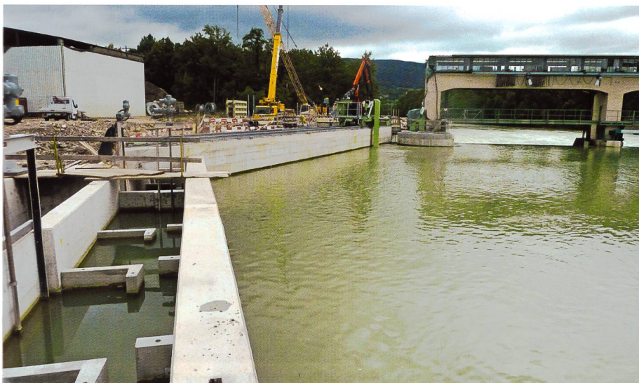
Bild 8. Neben naturnahen Umgehungsgerinnen können den Fischen auch technische Anlagen – wie dieser 2014 neu erstellte Schlitzpass beim Kraftwerk Rüchlig in Aarau – als Wanderhilfen dienen (Bild: Daniel Bernet, Fischereiinspektorat, Kanton Bern).
