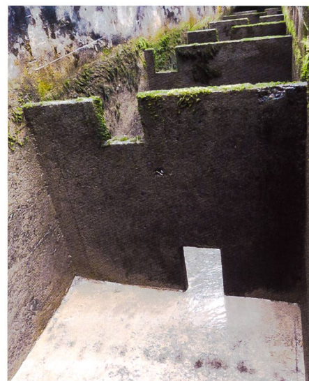
Bild 9. Die Dimensionierung dieser 1968 erstellten Fischaufstiegsanlage beim Wasserkraftwerk Bannwil (BE) kann den Ansprüchen der grösseren Wanderfische nicht genügen. Für die Zielarten Lachs und Barbe ist der Beckenpass – mit seinen Schlupflöchern und Kronenausschnitten – zu klein und muss deshalb saniert werden (Bild: Daniel Bernet, Fischereiinspektorat, Kanton Bern).
