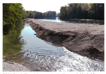
Bild 6. Durch Kiesschüttungen in den Fluss – wie hier bei Aarwangen (BE) im September 2013 – werden die durch Wehranlagen von Kraftwerken und Geschiebesammlern verursachten Geschiebedefizite teilweise ausgeglichen (Bild: Daniel Bernet, Fischereiinspektorat, Kanton Bern).
