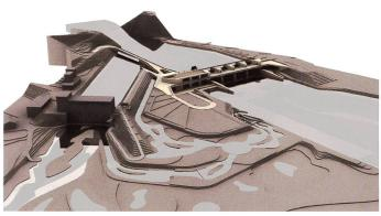
Bild 4. Sicht auf gesamte Kraftwerksanlage Hagneck mit Umgehungsgerinne im Vordergrund und geplante Renaturierung (linke Bildecke) (Quelle: Planerteam).
