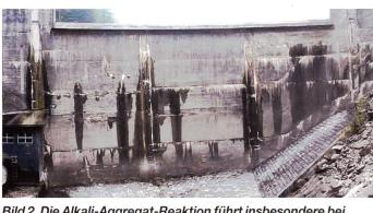
Bild 2. Die Alkali-Aggregat-Reaktion führt insbesondere bei Staudämmen zu einer Rissbildung. Diese ist im fortgeschrittenen Stadium als Rissnetz an der Oberfläche sichtbar. (Foto: Johannes Maier).
