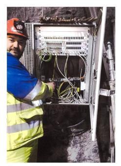
Bild 3. In allen 300 Notrufstationen sitzen Netzteile und Stromversorgungen von Puls
