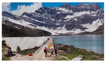
Bild 4. Der Salanfer Staudamm oberhalb von Martigny (VS) wurde vor zwei Jahren saniert, nachdem AAR-bedingte Risse aufgetreten waren. (Foto: Cyrille Dunant).
