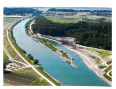
Der acht Kilometer lange Hagneckkanal ist das Herzstück der Juragewässerkorrektion. Er leitet seit 137 Jahren das Wasser der Aare in den Bielersee. Ohne das Bauwerk würde der Fluss das Seeland immer wieder überfluten. Die erhöhten und verstärkten Dämme fallen kaum mehr auf. Die Erweiterung des Gewässerraumes mit Seitenarm hingegen wirken landschaftsprägend. (Foto: AWA).
