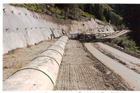
Bild 2. Die neu erdverlegte Druckleitung vor der Überdeckung (Foto: SWV/Pfa).
