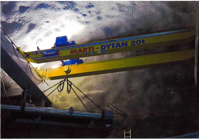
Bild 1. Der 20 t Zweiträger-Laufkran bringt die neuen Druckrohre in den Stollen ein.
