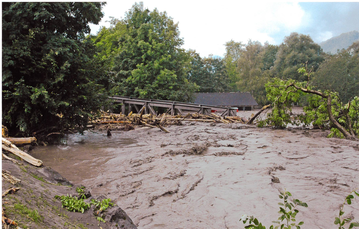
Bild 2. Zerstörte Eisenbahnbrücke der Zentralbahn (August 2005).
