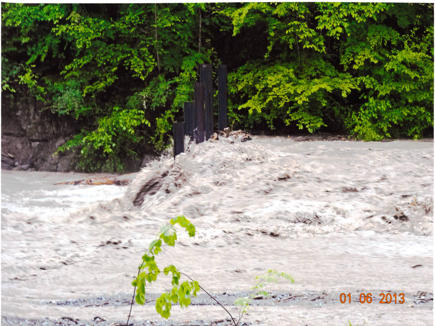
Bild 9. Wirkungsweise Holzurückhalterechen im Geschiebesammler (Ereignis 31. Mai/1. Juni 2013).
