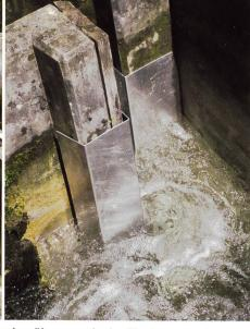
Bild 3. Mit Aluminiumblech ummantelter Beckenübergang in der Fischtreppe als Krebssperre. Links vor und rechts nach dem Einbau.
