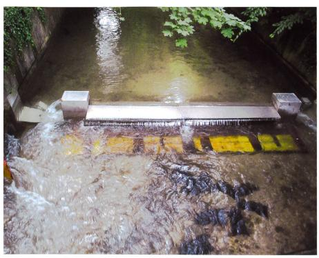
Bild 1. Fischpassierbare Krebssperre mit seitlichen Durchgängen für die Fische.
