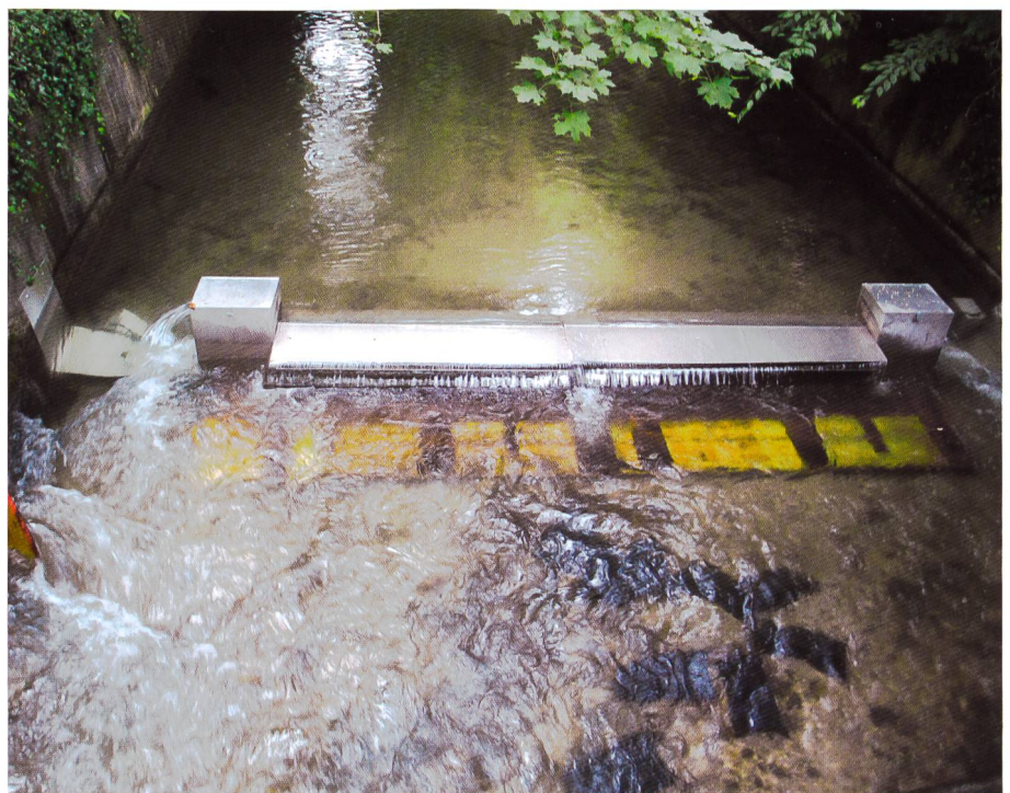
Bild 1. Fischpassierbare Krebssperre mit seitlichen Durchgängen für die Fische.
