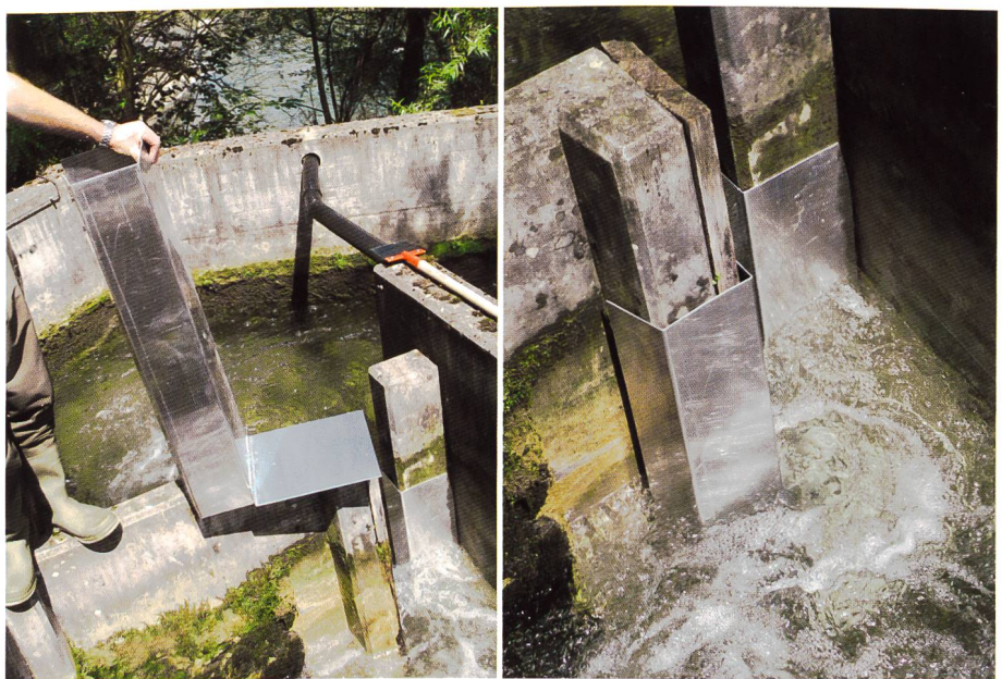
Bild 3. Mit Aluminiumblech ummantelter Beckenübergang in der Fischtrappe als Krebssperre. Links vor und rechts nach dem Einbau.
