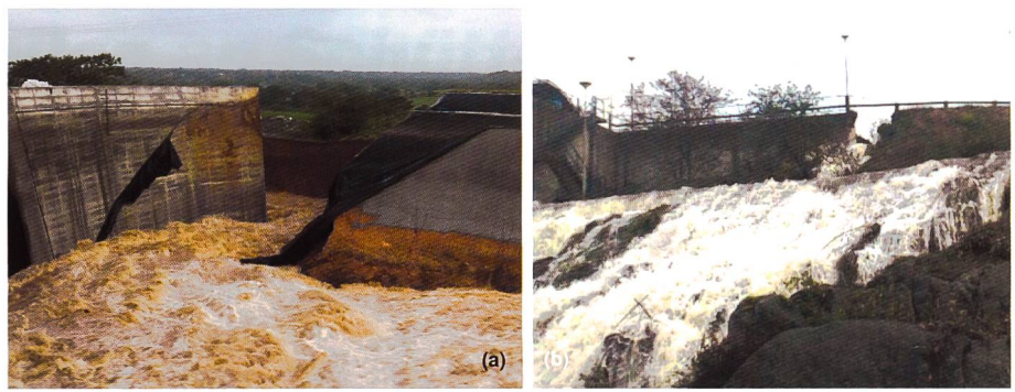
Bild 3. Beispiele von Damnbrüchen der vergangenen Jahre: (a) Versagen eines homogenen Schüttdammes in Panama (Messerklinger, 2014) (b) Dambruch eines gezonten Schüttdammes in Schweden (Ekström, 2012).
