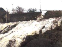
Bild 3. Beispiele von Dammbrüchen der vergangenen Jahre: (a) Versagen eines homogenen Schüttdammes in Panama (Messerklinger, 2014) (b) Dammbruch eines gezonten Schüttdammes in Schweden (Ekström, 2012).
