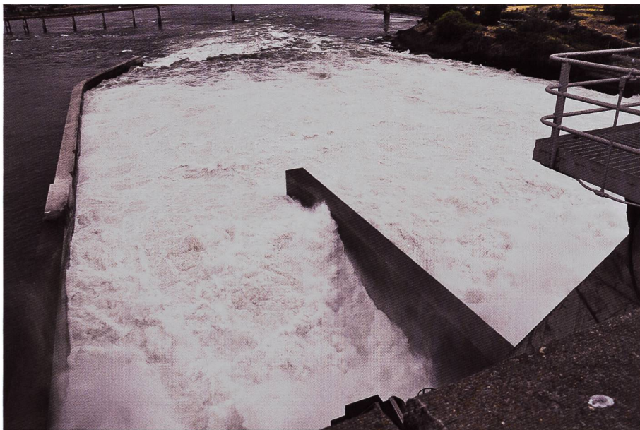
Bild 14. Leitwand (links) für den Fischabstieg, um Prädation zu verringern (Foto: VAR).
