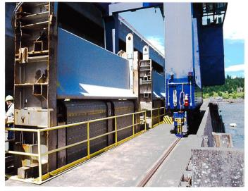
Bild 11. Element mit umlaufendem Rechen (Travelling Screen) an der Oberfläche am Bonneville Dam (Foto: VAR).
