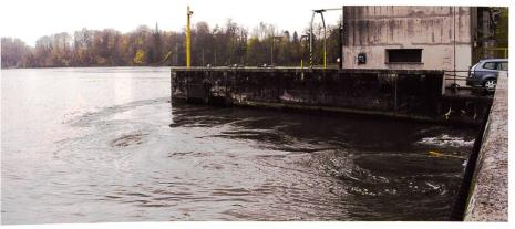
Bild 2. Strömungsablösung am Trennpfeiler (Bild VAW).
