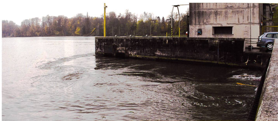
Bild 2. Strömungsablösung am Trennpfeiler (Bild VAW).
