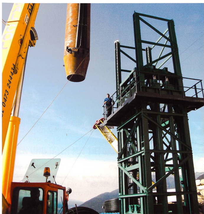
Bild 1. Positionierung des 1. Rohres mittels Autokran.
