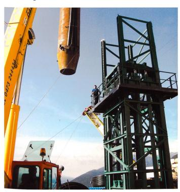
Bild 1. Positionierung des 1. Rohres mittels Autokran.
