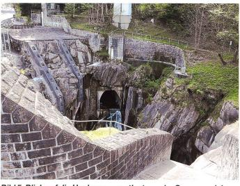
Bild 5. Blick auf die Hochwasserentlastung der Sperre und den Auslauf des SBT Pfaffensprung (Foto: VAW).
