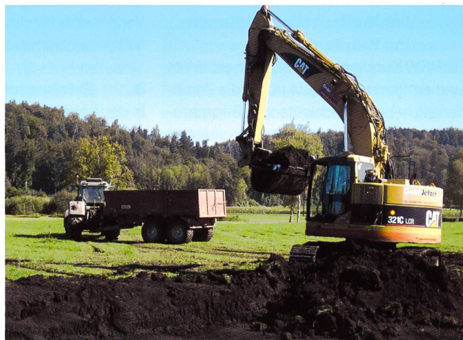
Bild 2. Abtrag des Torfbodens mit Raupenbagger, September 2013.
