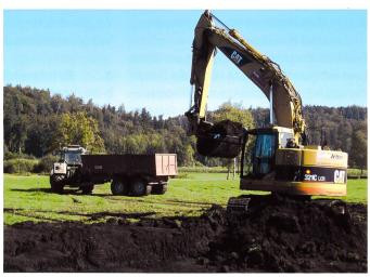
Bild 2. Abtrag des Torfbodens mit Raupenbagger, September 2013.
