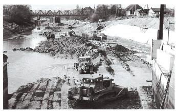
Bild 9. Unterwasserausbaggerung mit trockengelegter Aare (Foto: BKW Energie AG).
