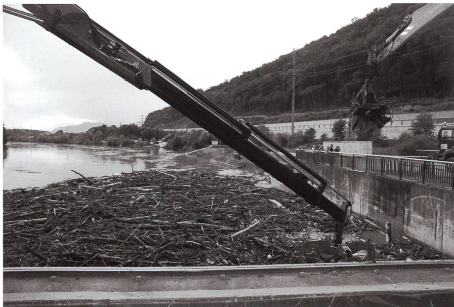
Bild 18. Geschwemmsele-Entnahme beim Kraftwerk Ruppoldingen im Juli 2014.
