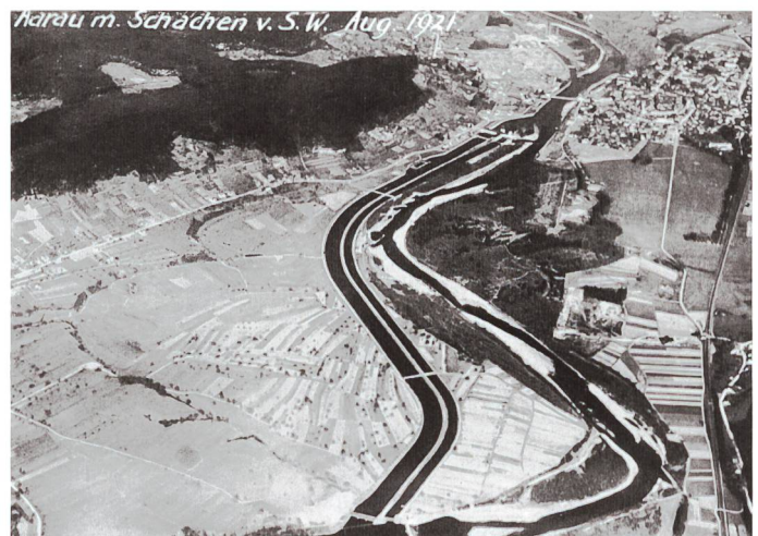
Bild 5. Luftaufnahme der Anlagen des Kraftwerks Aarau mit dem Kanal links und dem Aarelauf rechts im August 1921.
