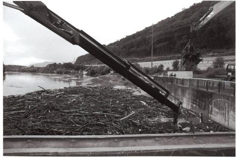
Bild 18. Geschwemmselentnahme beim Kraftwerk Ruppoldingen im Juli 2014.
