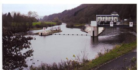
Bild 3. Wasserkraftwerk Unkelmühle an der Sieg NRW, Blick vom Oberwasser. Pilotanlage für den Fischschutz (Fischabstieg) mit drei Rechenfelder mit einem 10 mm Vertikalrechen und Rechenreiniger (Foto: A. Peter).
