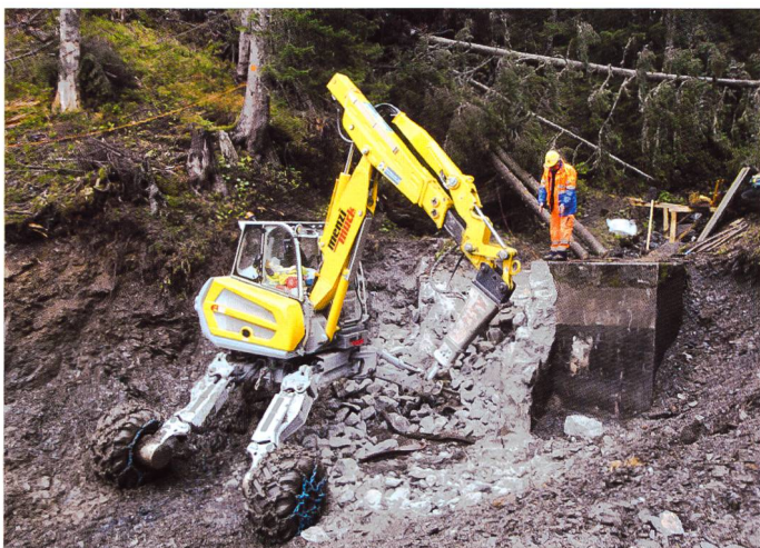
Bild 4. Abbrucharbeiten an der Wasserfassung des Moosbachs im September 2013.
