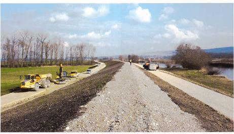
Bild 1. Erhöhter und verstärkter Hochwasserdamm am Hagneckkanal (Foto: zvg).
