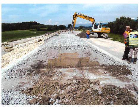
Bild 2. Einbau der erodierbaren Dammkrone als Überlastsicherung (Foto: zvg).
