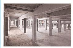
Bild 3. Infrastrukturgeschoss unterhalb der Versuchshalle mit abgedecktem Rücklaufkanal und Stichleitung im Hintergrund.
