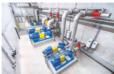
Bild 4. Pumpenraum mit sieben drehzahlregulierten Kreislaspumpen.
