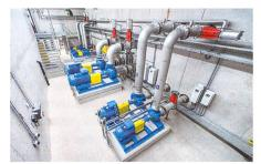
Bild 4. Pumpenraum mit sieben drehzahlregulierten Kreiselpumpen.
