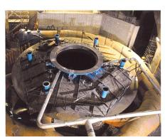
Bild 2. Einbau Peltonturbine in neuer Zentrale Handeck 3 (Foto: SWV/Pfa).
