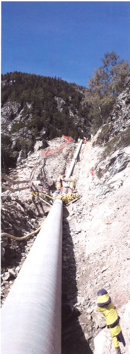
Bild 2. Die mit Faserzementmörtel beschichtete Stahlleitung wird in einem Rohrgraben verlegt, der später wieder verfüllt wird.
