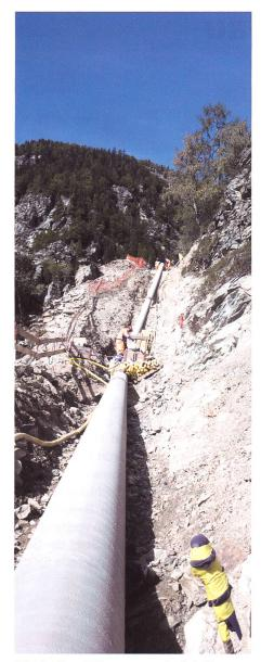
Bild 2. Die mit Faserzementmörtel beschichtete Stahlleitung wird in einem Rohrgraben verlegt, der später wieder verfüllt wird.
