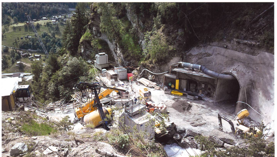
Bild 1. Der Vorplatz der Kaverne des KW Jungbach ist der einzige einigermaßen flache Bereich im Projektgebiet und wird daher für die Baustelleneinrichtungen verwendet.
