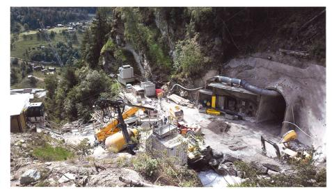
Bild 1. Der Vorplatz der Kaverne des KW Jungbach ist der einzige einigermassen flache Bereich im Projektgebiet und wird daher für die Baustelleneinrichtungen verwendet.
