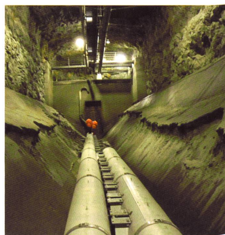
Bild 2. Grossanlage Wasserfassung Titer mit extrem grossem Anfall an abrasiven Sedimenten. Hier konnte die Schwallbildung durch Spülungen auf ein sicheres Mass verringert werden.
