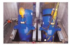
Bild 2. Die zwei baugleichen Kaplan-Turbinen im Dotierkraftwerk (Foto:EKW).
