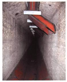
Bild 5. Steigerung der Effizienz und Betriebstüchtigkeit eines Entsanders mit verschlissenem Lamellenabzug: Sedimentabzug HSR und verschleissfeste Bodenbleche zur Sanierung der verschlissenen Sohle und Ecken.
