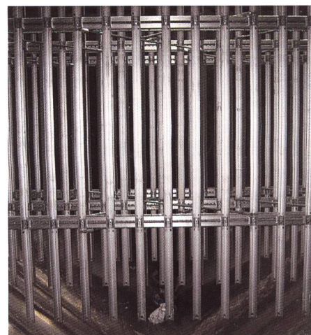
Bild 7. Bezuglich Zuverlässigkeit, Instandhaltung und Sicherheit optimierte, rostfreie Konstruktion eines Beruhigungsrechens.
