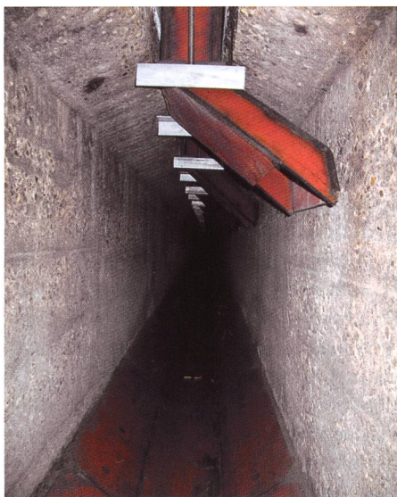
Bild 5. Steigerung der Effizienz und Betriebstüchtigkeit eines Entsanders mit verschlissenen Lamellenabzug: Sedimentabzug HSR und verschleissfeste Bodenbleche zur Sanierung der verschlissenen Sohle und Ecken.
