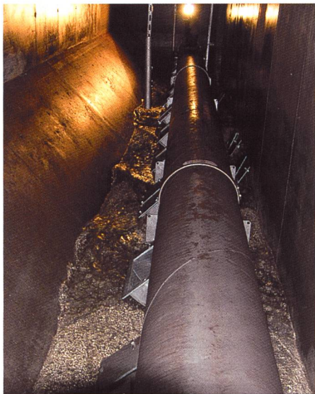
Bild 4. Effizienter Sedimentabzug mit kostengünstigem Bauwerk und sicherem Inspektionszugang.
