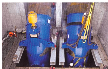
Bild 2. Die zwei baugleichen Kaplan-Turbinen im Dotierkraftwerk (Foto:EKW).
