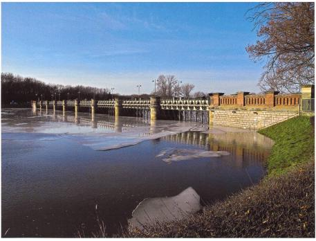
Bild 3. Eisbildung bei Vollstau bedeutet höchste Belastung für die Wehrkonstruktion.
