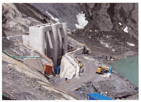
Bild 3. Ein- und Auslaufbauwerk im Stausee Mutt des Pumpspeicherwerkes Limmern Linthal 2015 (Foto Schleiss, Juli 2013).
