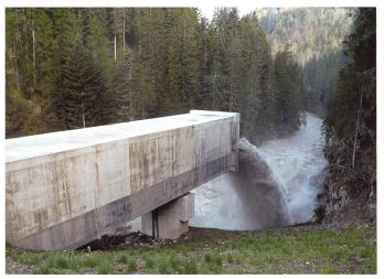
Bild 3. Bei einer Hochwassersituation führt der 2012 eröffnete Umleitstollen das Wasser der Albula am Stausee Solis (GR) vorbei und schützt diesen vor Verlandung (Foto: ewz).
