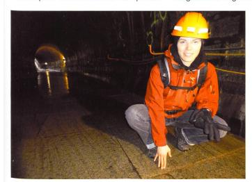
Bild 2. ETH-Forscherin Michelle Hagmann begutachtet die Granitplatten am Boden des Umleitstollens Pfaffensprung im Kanton Uri. Im ersten Jahr der Untersuchung wurden die Platten durch Geschiebe durchschnittlich um 0.3 mm abgetragen.
