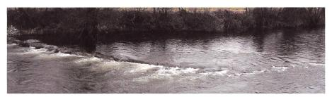
Bild 3. Inklinante Lenkbuhne in der Mur bei St. Michael/Obersteiermark bei Niedrigwasserabfluss (Foto: Otmar Grober).
