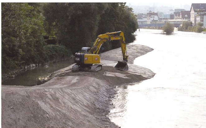
Bild 2. Kiesschüttung Breitensteinstrasse in der Limmat. Blick gegen die Fliessrichtung. Photo: AWEL, Bau- direktion Kanton Zürich.
