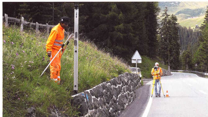
Bild 9. Nivellement im Rutschhang Natons, Stauanlage Marmorera.
