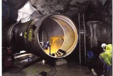
Figure 9. Illustration de la découpe du puits blindé existant et de la mise en place du Té de liaison.
