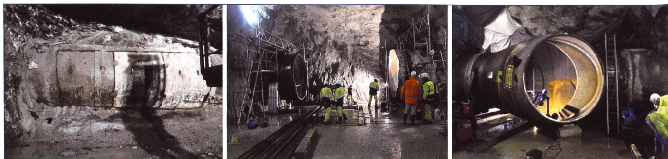
Figure 9. Illustration de la découpe du puits blindé existant et de la mise en place du Té de liaison.
